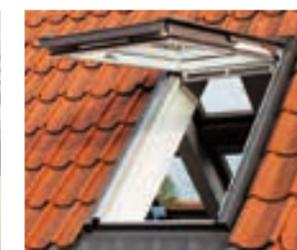
Montage des neuen Eindeckrahmens und Einhängen des neuen Fensterflügels. Fertig!
