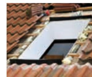
Ausbau des alten Fensters. Die Innenverkleidung bleibt unbeschädigt erhalten.
