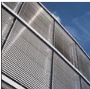
Sowohl die Lamellen der Außenraffstore, die sich durch unterschiedliche Geometrien auszeichnen, als auch die Führungsschienen gewährleisten eine hohe Stabilität und sorgen, ebenso wie Außenjalousien, für eine stufenlose Lichtregulierung und ein optimales Raumklima.
