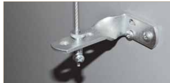
Seilabspannung Außenjalousie
