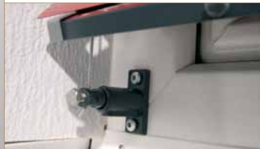
Seilabspannung Außenraffstore
