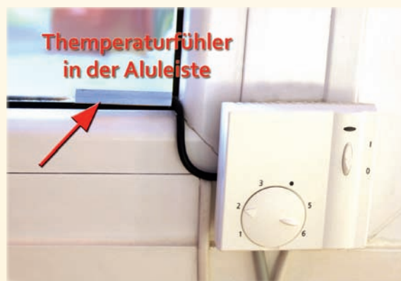
Der Standardthermostat kann auch versteckt neben dem Fenster (z.B.: in einem Kasten) montiert werden.
